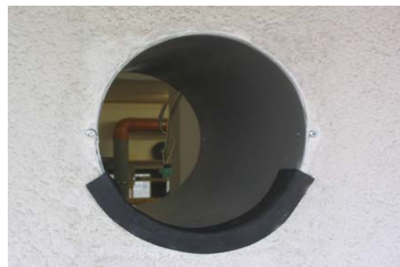
Bild 4: Befestigungselemente waagrecht!
