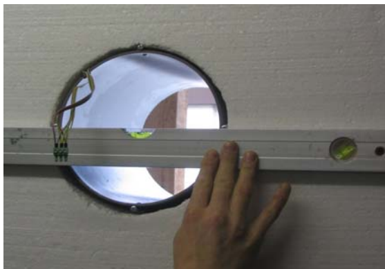
Bild 3: Waagerechter Einbau
